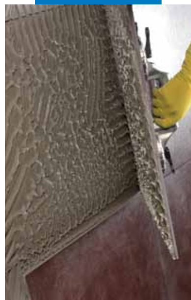
Verificarea acoperirii cu adezivul Kerabond T-R pe spatele plăcii ceramice - acoperire totală de 100%
