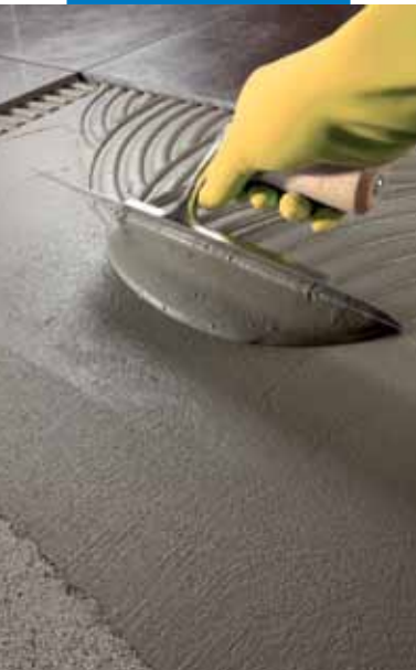
Aplicarea adezivului Kerabond T-R pe pardoseală
