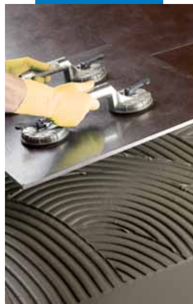
Aplicarea plăcilor de gresie porțelanată de mari dimensiuni cu adezivul Kerabond T-R în amestec cu Isolastic
