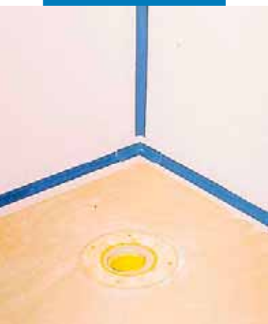
Hidroizolarea pereților unei băi cu Mapegum WPS și Mapeband
