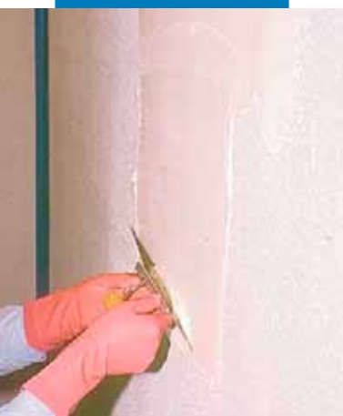
Întinderea unui strat de adeziv pe Mapegum WPS
