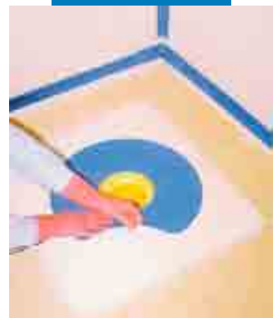
Montarea elementului special de Mapeband peste Mapegum WPS
