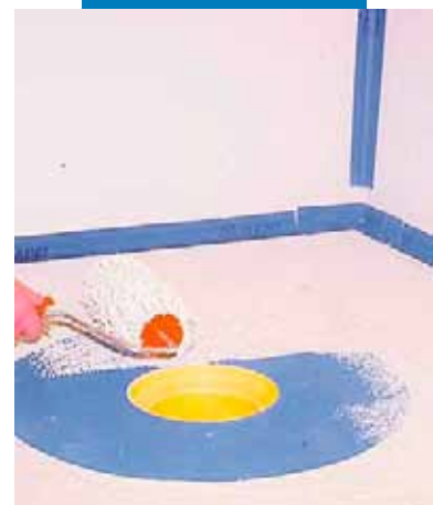
Înglobarea elementului special de Mapeband în Mapegum WPS
